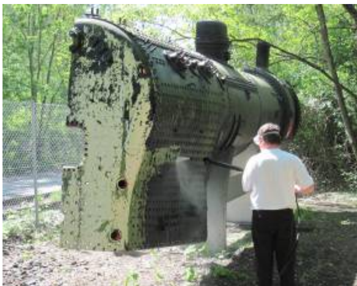
Schmutz und Anstrich werden mit dem Druckreiniger entfernt Foto: Frank Gründer
