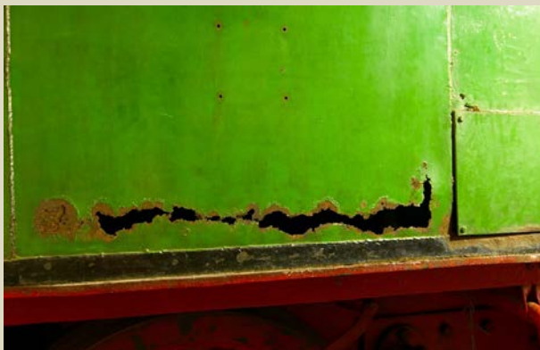
Durchrostungen an Vorratsbehältern
